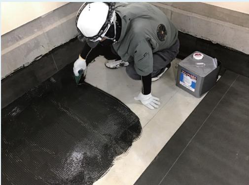
CAシート15（改質アスファルトルーフィング）をクリンアスNEOで張付ける
